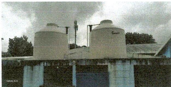
Foto1: Mejoramiento de módulo de Baños, Drenaje y Fosa Séptica.
