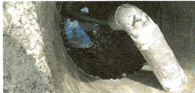
Foto 2: Mejoramiento de módulo de Baños, Drenaje y Fosa Séptica.
