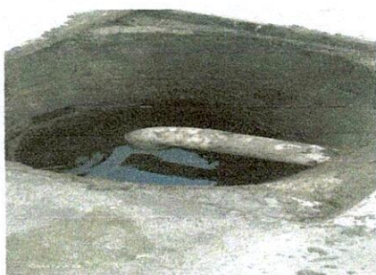
Foto 3: Mejoramiento de módulo de Baños, Drenaje y Fosa Séptica.
